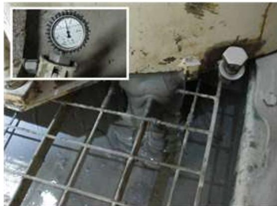
f) Austritt des zähflüssigen Baustoffs in die Betonpumpe (p bis 15 bar).
