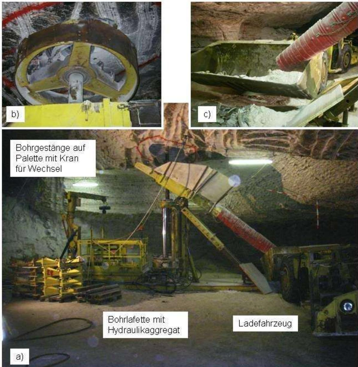
Abb. 3.11. Auffahrung des 1300mm-Großbohrlochs am Versuchsort 2. Sohle mittels Rolllochbohrmaschine GB-75. a) Übersichtsaufnahme der Vorortsituation mit aufgestellter Vertikalbohrlafette sowie Zubehör und Ladefahrzeug; b) Ansetzen der Bohrkronen mit Pilot; c) Detailansicht Schüttrinne zum Abführen des Bohrkleins und Abtransport mittels Lader.
