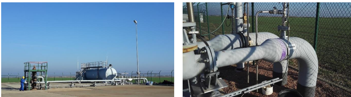
Abbildung 91: Übersicht Bohrplatz Kaverne C, Bohrlochkopf (links), Entnahmestellen Sole (rechts)
