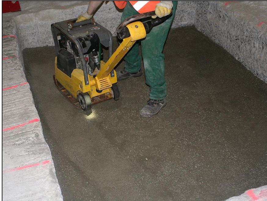
Abbildung 27: Vorverdichtung einer Lage mit der leichten Rüttelplatte RP1 (Versuchsmulde, STG-2 - OBSM)
