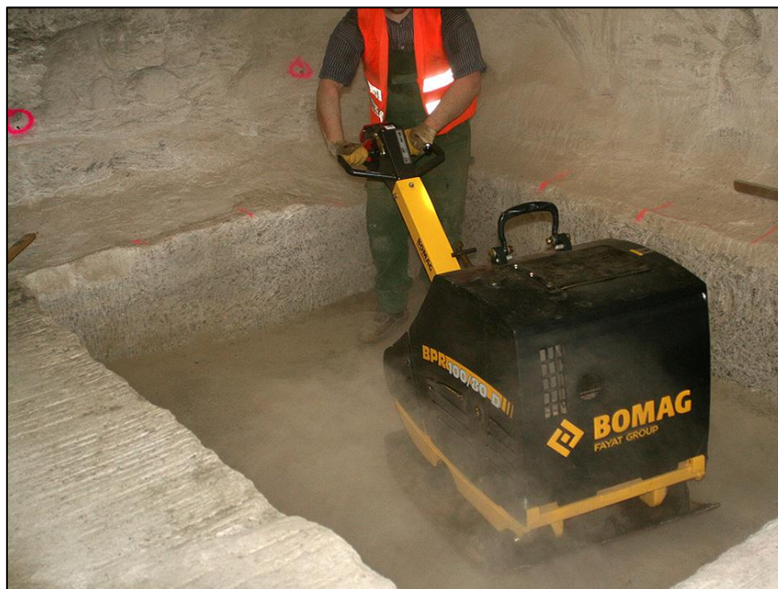
Abbildung 28: Staubentwicklung bei der Verdichtung mit der schwersten Rüttelplatte RP3 (Versuchsmulde 1, STG-2 - OBSM)
