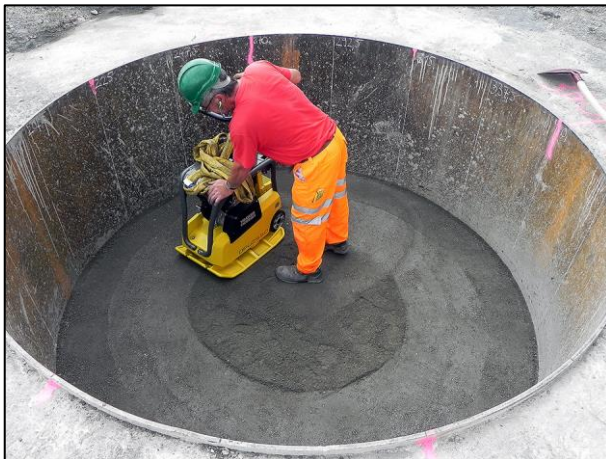
Abbildung 36: Einsatz der leichten Vibrationsplatte RP1 bei der leichten Vorverdichtung
