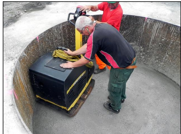
Abbildung 37: Einsatz der schweren Vibrationsplatte RP3 bei der schweren Vorverdichtung
