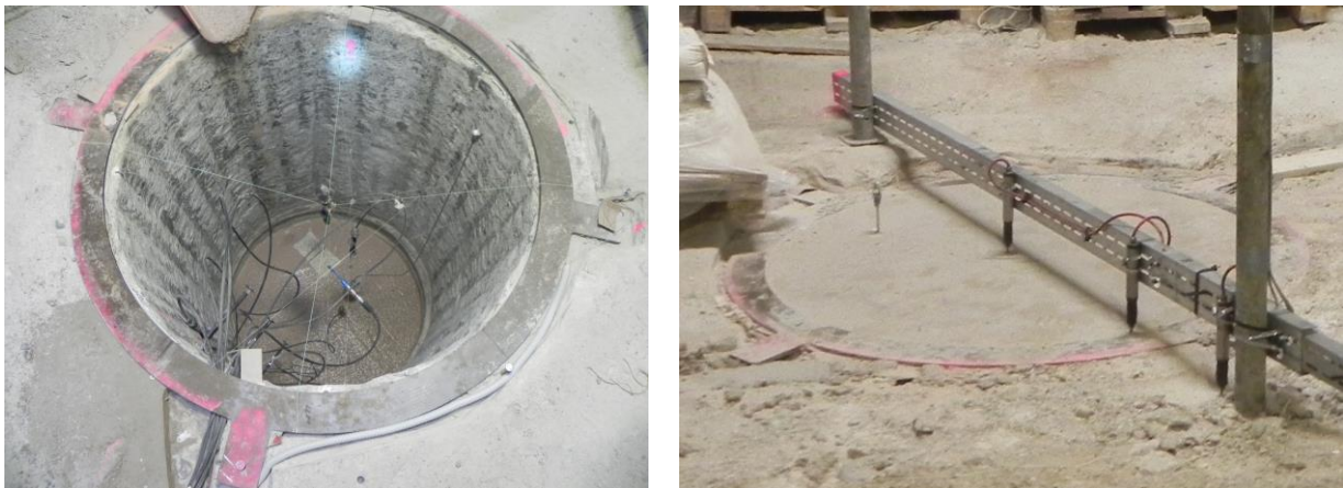
Abbildung 63: Einbau des MgO-Betons (links) und fertig gestelltes Bauwerk (rechts)
