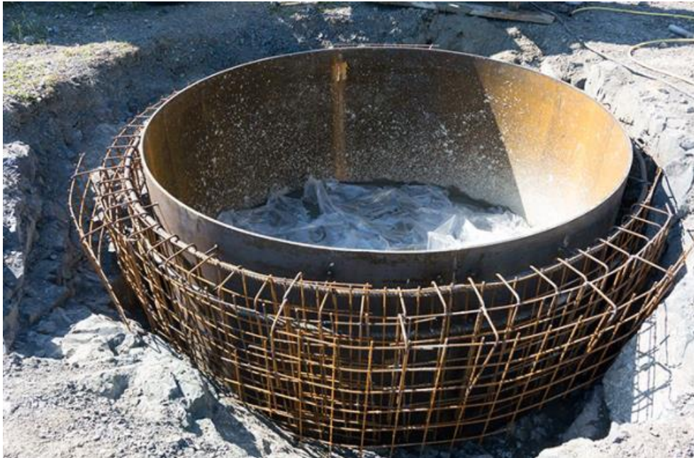
Abbildung 35: Stahlringkonstruktion für den Gesenkversuch zu Erprobung der Impulsverdichtung
