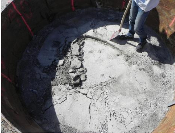
Abbildung 50: Zustand der Oberfläche nach der Impulsverdichtung im Gesenkversuch 2017
