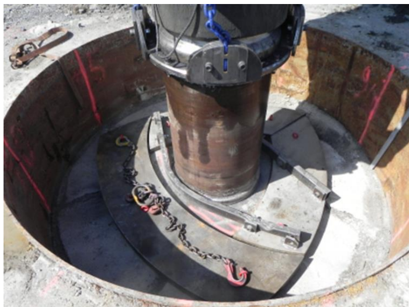
Abbildung 45: Neuer Verdichterfuß mit 3 bogenförmigen Beschwerungsplatten seitlich
