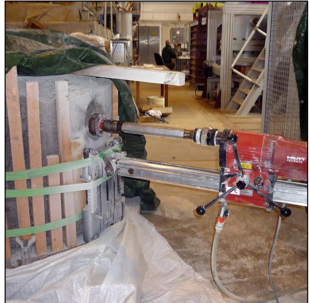
Abbildung 32: Luftgespülte Kernbohrung in der gewonnenen Probe (Bohrung 2)
