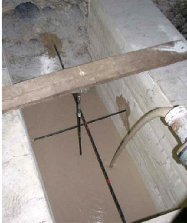
**Abb. 2.13** Einbringen des Sorelbetons A1 in eine Widerlagerbox /BFS 09/
