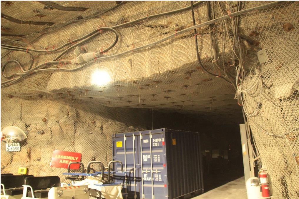
Abbildung 28: Beispiel für intensive Konturschädigung an einer Hauptstrecke der WIPP Site
