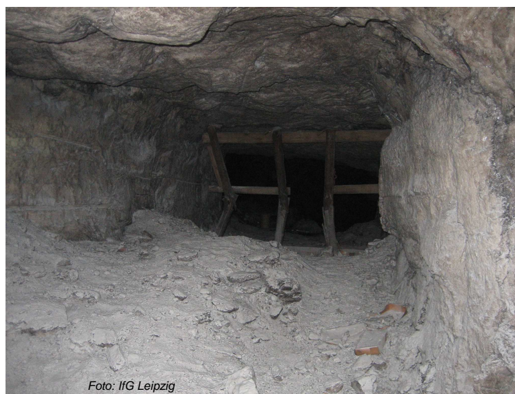
Abb. 66 Foto der starken Dilatanz und Schädigung in der Auflockerungszone um eine Verbindungsstrecke zwischen zwei Abbaukammern (hier: Kammern IV und V) herum, das die Berechnungsergebnisse in Abb. 65 unterstützt.
