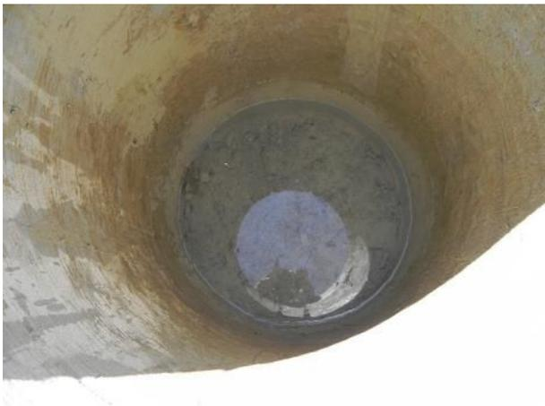
Abbildung 90: zugetretenes Wasser im Bohrloch
