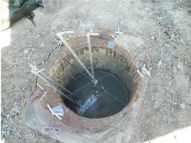
Abbildung 98: Trennfolie zwischen Kontrollkammer und Betonwiderlager
