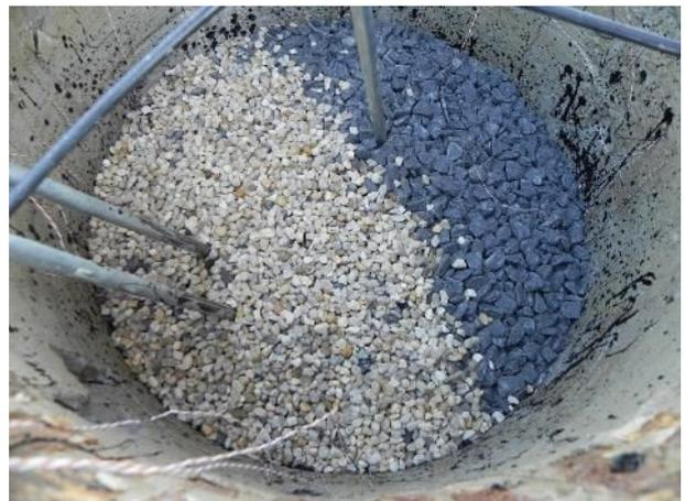
Abbildung 97: abgestufter Kies in der Kontrollkammer
