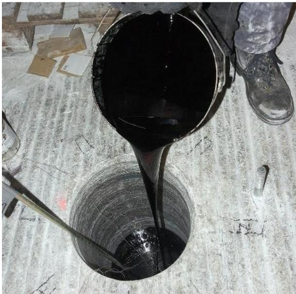
Abbildung 9: Verguss des Abdichtbitumens AZALT 70/100
