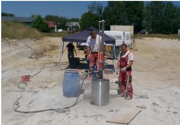
Abbildung 65: Herstellung der Bohrlöcher
