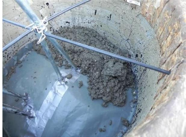
Abbildung 99: Einbau des Betonwiderlagers
