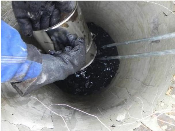
Abbildung 94: Einbau des Steinasphalts
