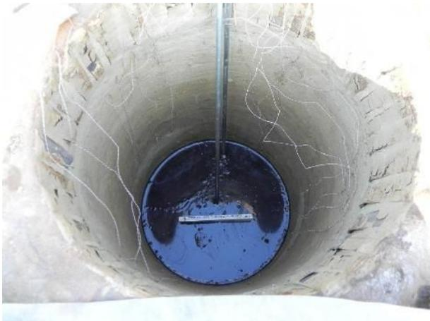
Abbildung 79: abgekühlte untere Sperrschicht
