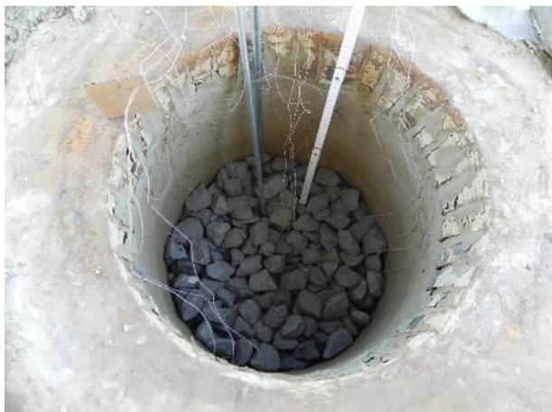
Abbildung 81: eingebauter Schotter des Dichtelements
