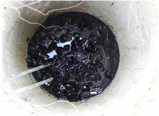
Abbildung 95: Dichtelement aus Steinasphalt
