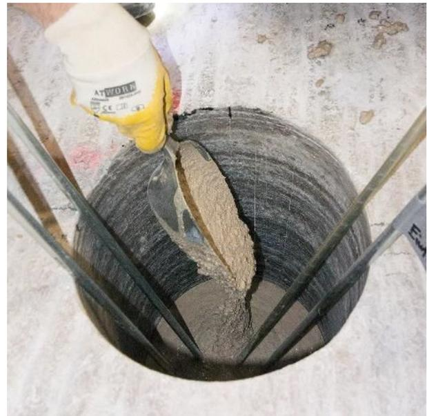
Abbildung 21: Betonage des Widerlagers
