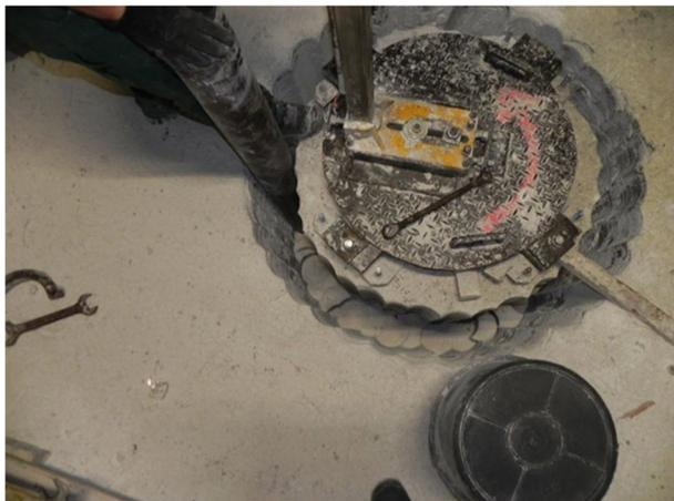
Abbildung 18: Loch-an-Loch-Bohren
