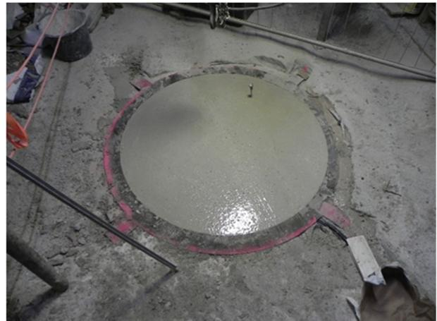
Abbildung 23: Ende der Betonage
