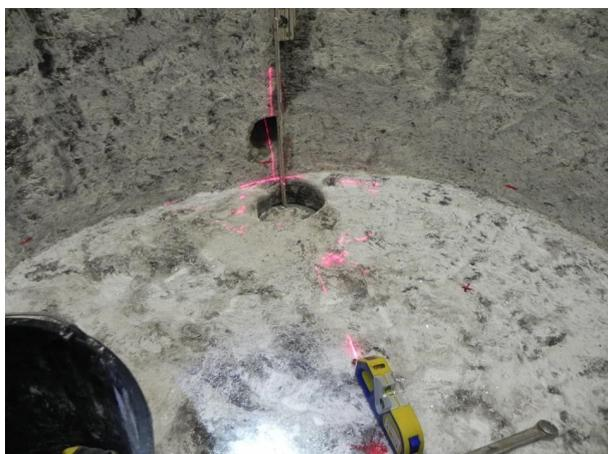
Abbildung 20: Austrittspunkt Schrägbohrung
