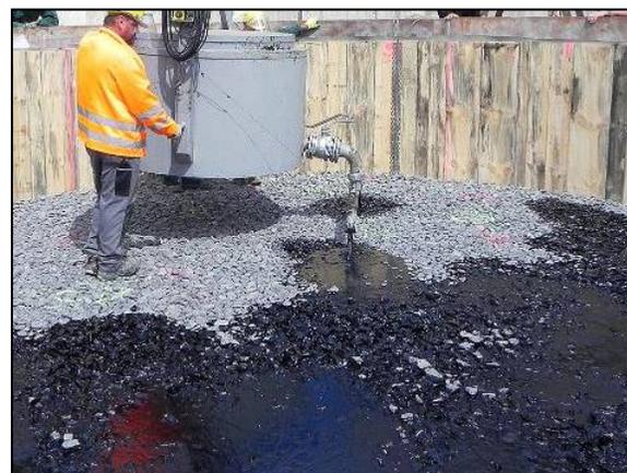
Abbildung 6-2: Großversuch zur Optimierung der Einbautechnologie einer mit Bitumen verfüllten Schottersäule
